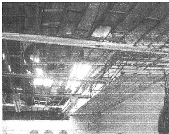
Foto 10. Cubierta de la parte frontal en buenas condiciones
