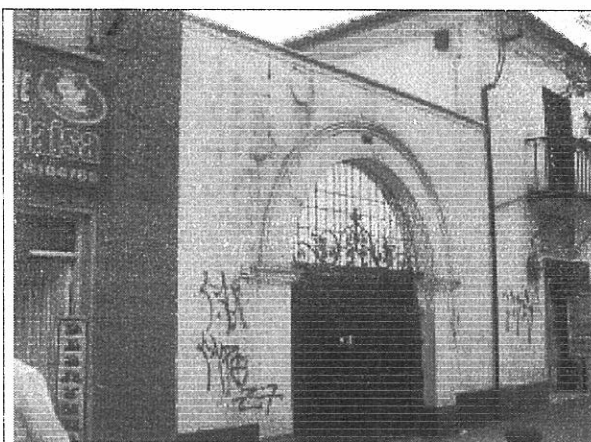
Foto 1. Vista general del muro de fachada
