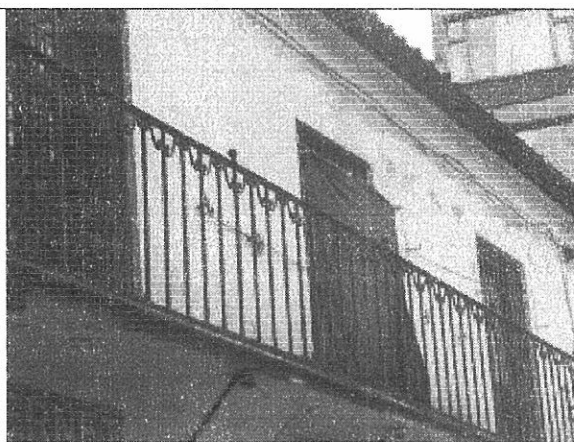
Foto 2. Muro de fachada en el sector de la edificación en buen estado
