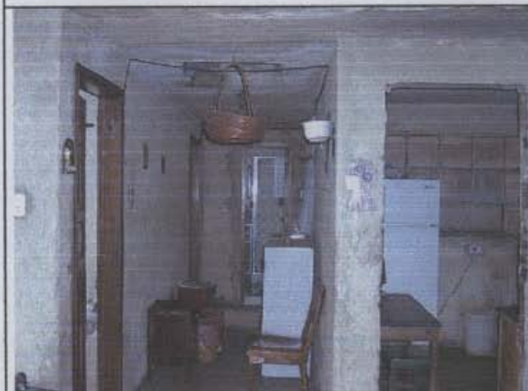
Foto 7. Vista interna general de los muros de segundo piso, sin acabados.
