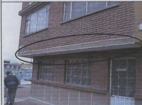
Foto 3. Costado sur del inmueble, sin afectaciones externas apreciables.
