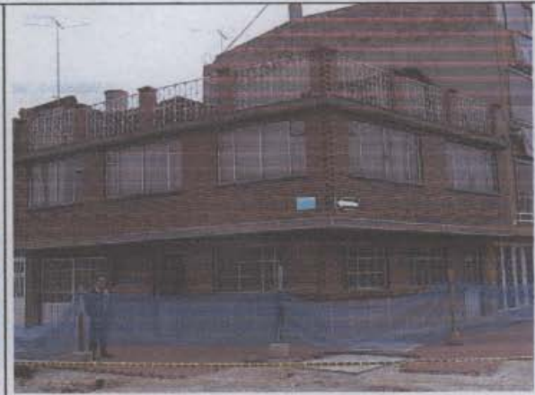
Foto 2. Fachada principal y lateral, sin afectaciones estructurales apreciables.
