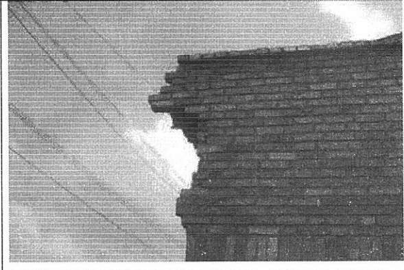
Foto 4. Elementos de mampostería sueltos en culata costado oriental
