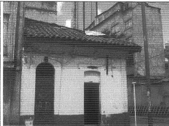
Foto 1. Vista general de la fachada del inmueble costado sur
