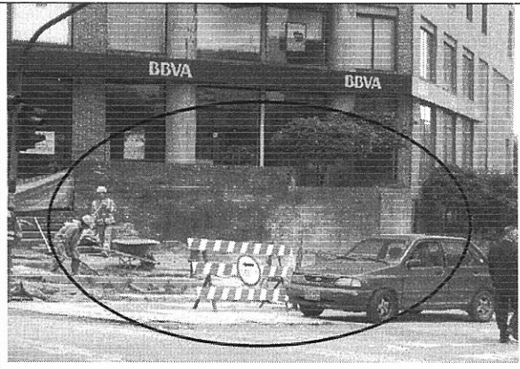
Foto 2. Vista del muro sobre la calle 33
