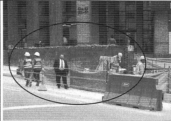
Foto 1. Vista general del muro sobre la carrera 13
