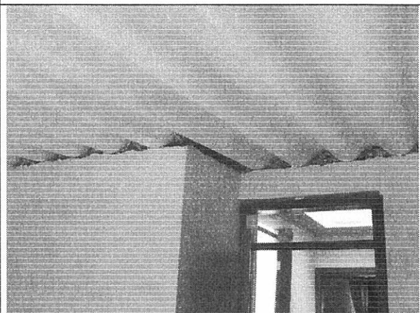
Foto 14. Tejas de cubierta en buen estado
