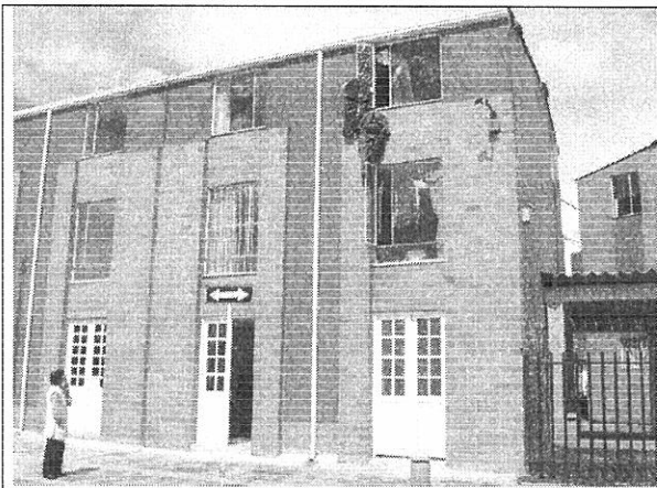
Foto 1. Aspecto general de la fachada del inmueble hacia la calle
