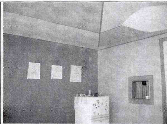
Foto 2. Muros de primer piso sector frontal en buen estado
