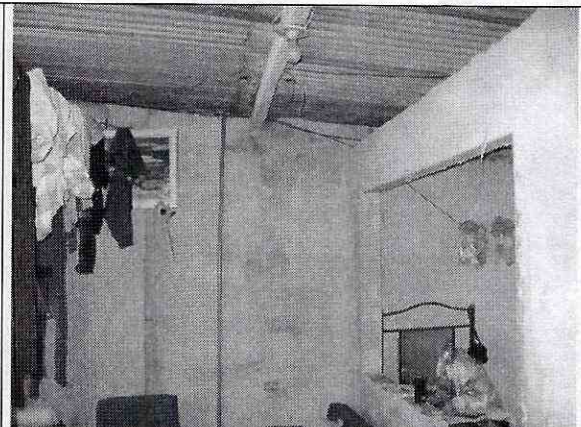
Foto 4. Muros internos y cubierta en buen estado
