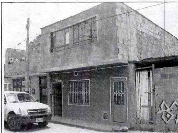
Foto 1. Aspecto general de la fachada del inmueble
