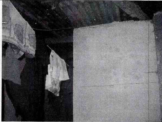
Foto 3. Muros del segundo piso sin daños
