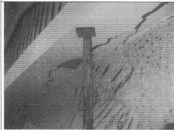
Foto 7. Fisuras en vigas de cubierta
