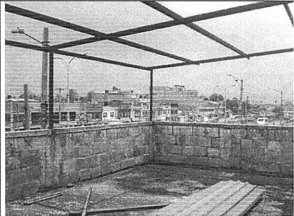
Foto 12. Estructura metálica y placa del nivel de altillo
