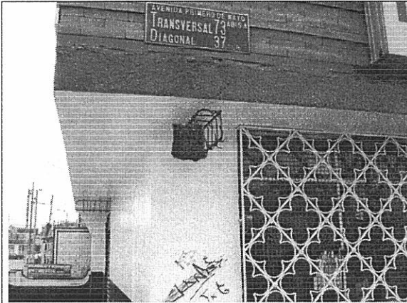
Foto 3. Intervención en fachada para reforzamiento
