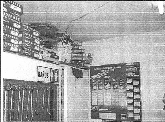
Foto 4. Muros internos del local en buen estado
