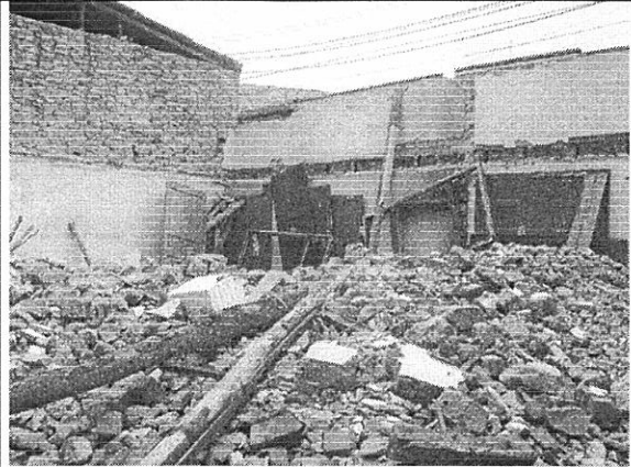
Foto 4. Se han retirado los muros perpendiculares
