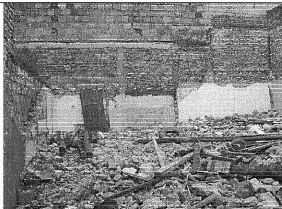
Foto 7. Muro posterior parcialmente demolido
