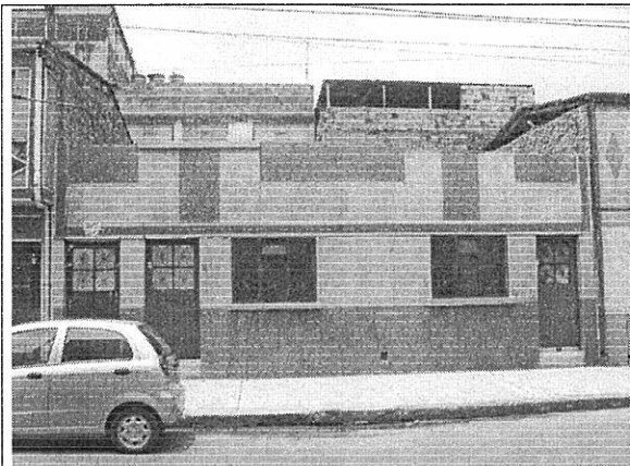
Foto 1. Vista general del muro de fachada
