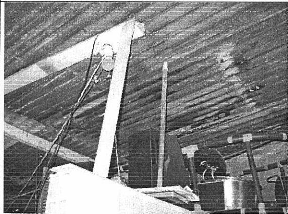
Foto 7. Cubierta en lámina metálica sin daño aparente
