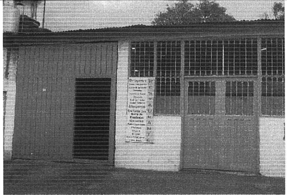
Foto 2. Fachada costado norte
