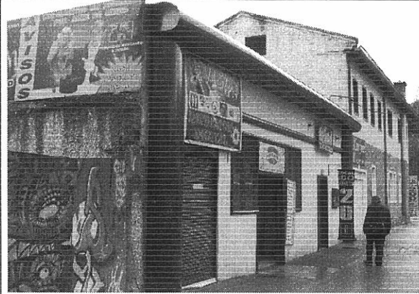
Foto 1. Fachada costado sur
