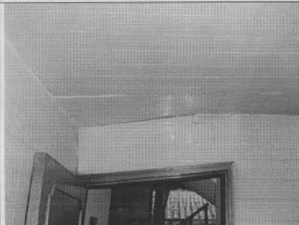
Foto 19. Deformaciones de marcos de puertas.
