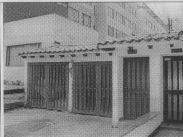
Foto 1. Fachada de la Edificación en las condiciones presentes al momento de la visita.
