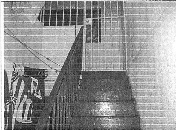
Foto 9. Escaleras en buenas condiciones
