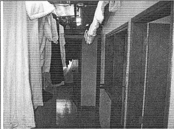
Foto 10. Muros de niveles superiores en buen estado
