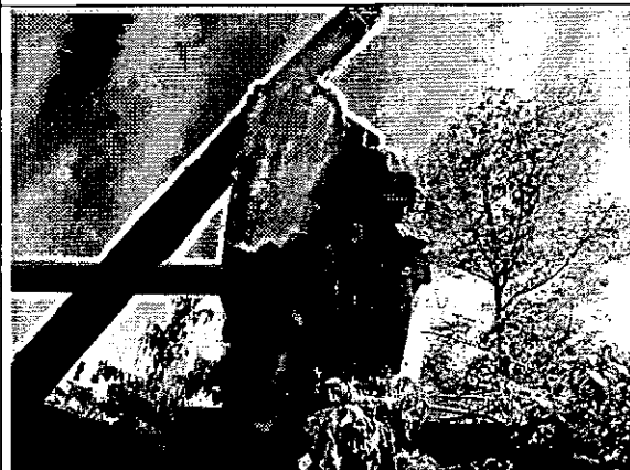
Foto 11. Bloques con posibilidad de caída
