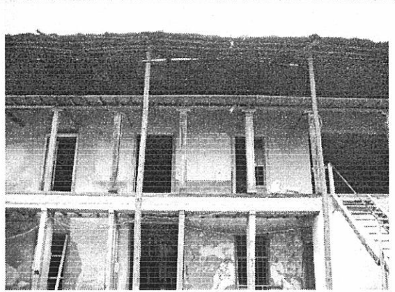
Foto 14. Apoyos provisionales de entpiso y cubierta.
