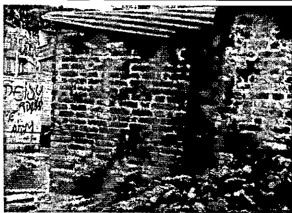
Foto 3. Humedad en muro costado norte
