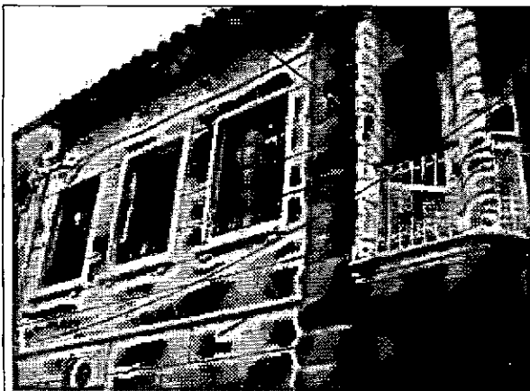
Foto 1. Vista general de la fachada del inmueble
