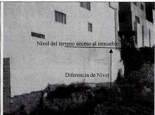
Foto 2. Fachada costado occidental
