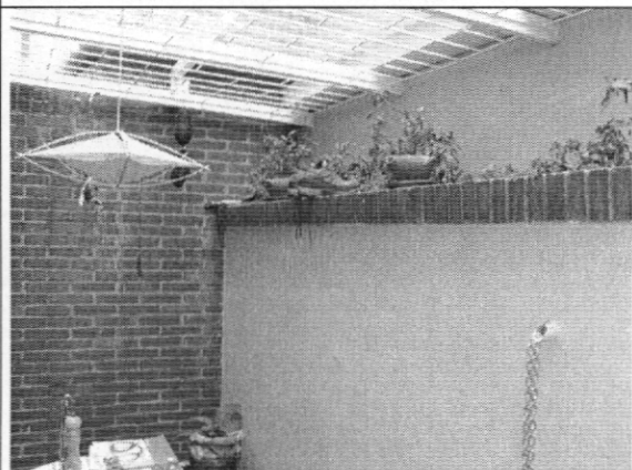
Foto 8. Elementos del patio posterior sin afectaciones
