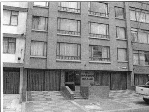
Foto 1. Fachada del edificio donde se encuentran los apartamentos objeto de la querrela
