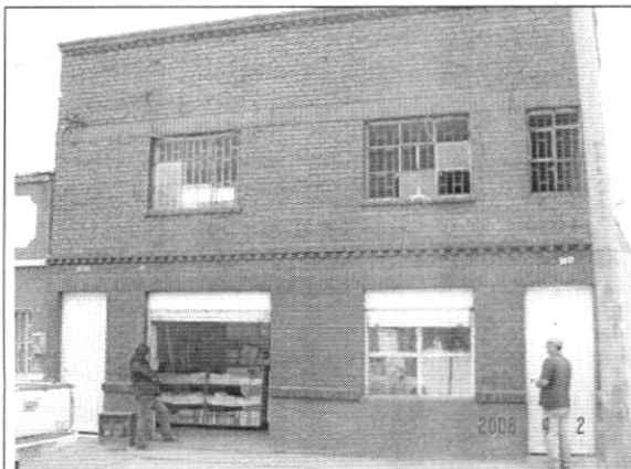
Foto 1. Fachada del inmueble objeto de la querrela
