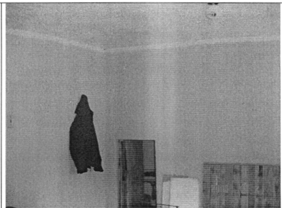
Foto 2. Muros internos del primer piso sin afectaciones
