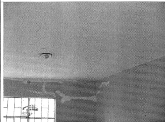
Foto 7. Cielo raso bajo cubierta en buenas condiciones
