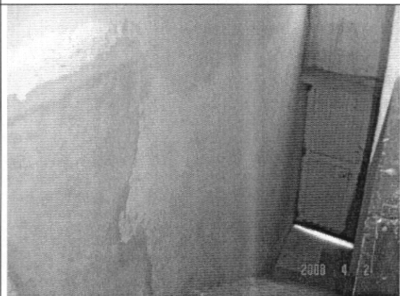
Foto 8. Reconstrucción del muro de lindero
