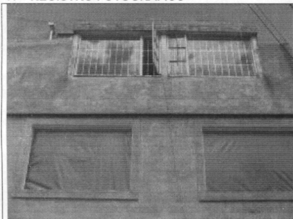
Foto 1. Vista general de la fachada del inmueble, costado occidental
