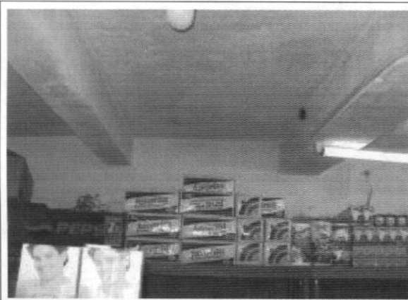
Foto 3. Muros internos de locales comerciales en buen estado
