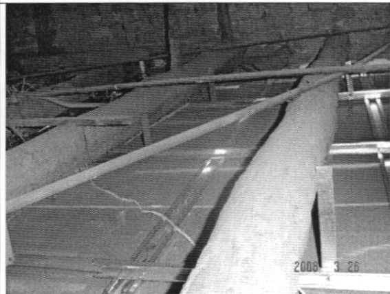
Foto 6. Estructura de cielo raso del sector frontal
