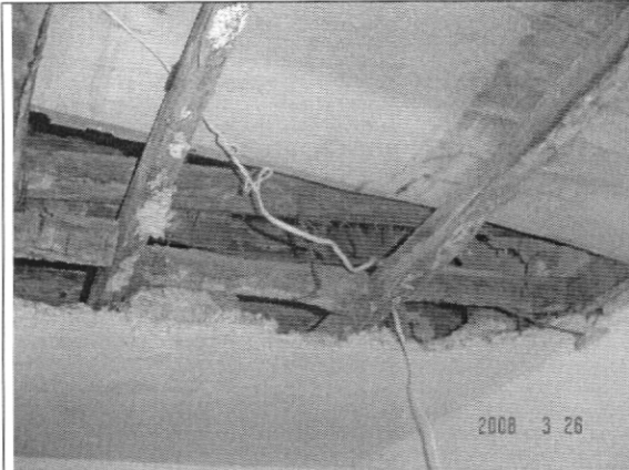
Foto 3. Se ha retirado parte del cielo raso
