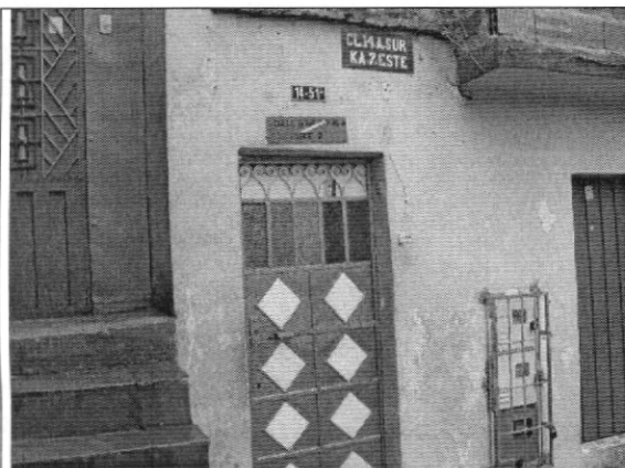
Foto 1. Fachada del inmueble donde se encuentra el muro de lindero objeto de la querrela
