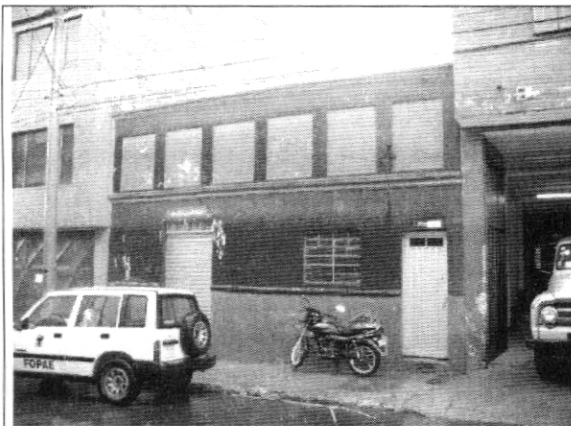
Foto 1. Fachada del inmueble objeto de la querrela
