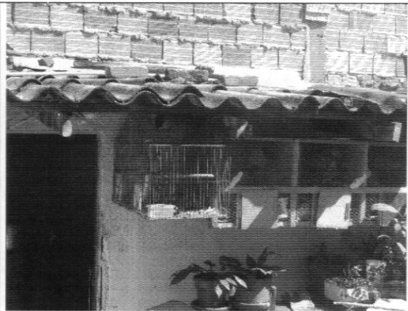
Foto 4. Muros edificación en buen estado
