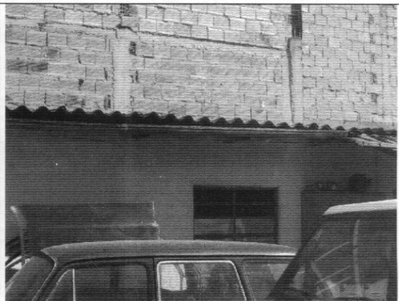
Foto 6. Cubierta construcciones internas
