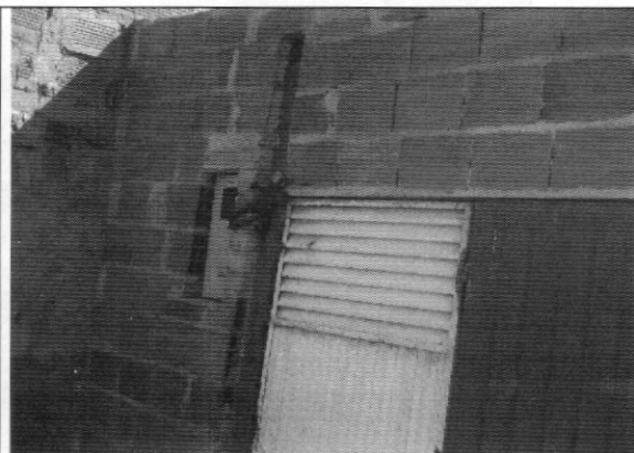
Foto 2. Muros de fachada en bloque en buen estado
