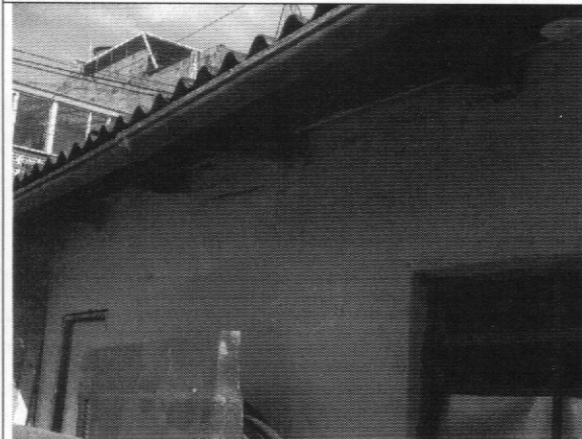
Foto 5. Construcción posterior en buenas condiciones
