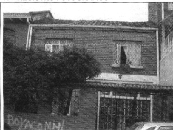
Foto 1. Vista general del inmueble
