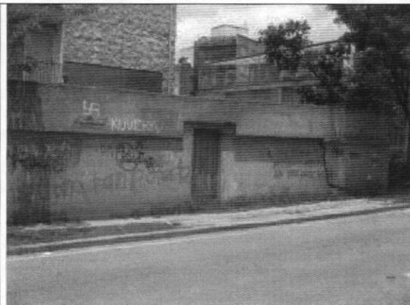
Foto 1. Vista general del muro, costado oriental
