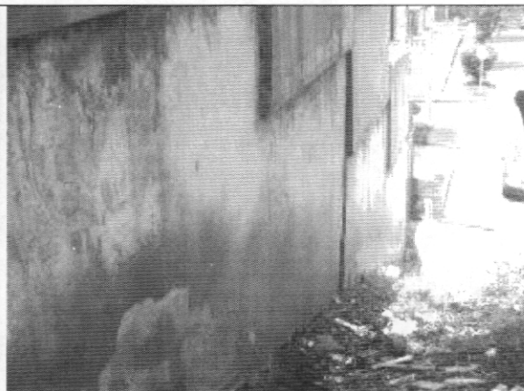
Foto 2. Vista del muro costado norte
