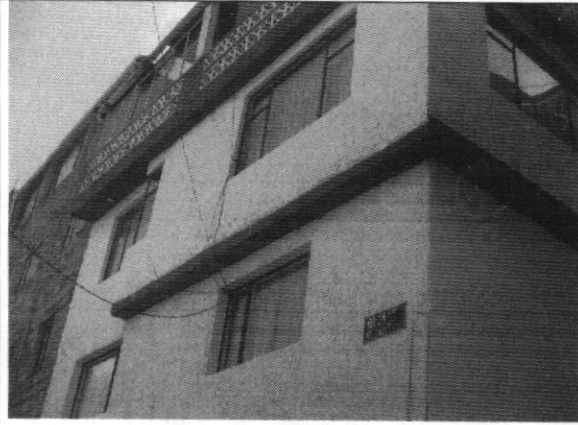
Foto 1. Vista fachada costado occidental
