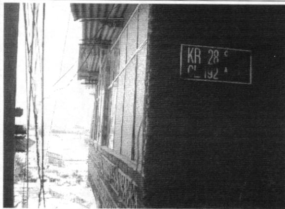
Foto 3. Fachada principal, costado sur
