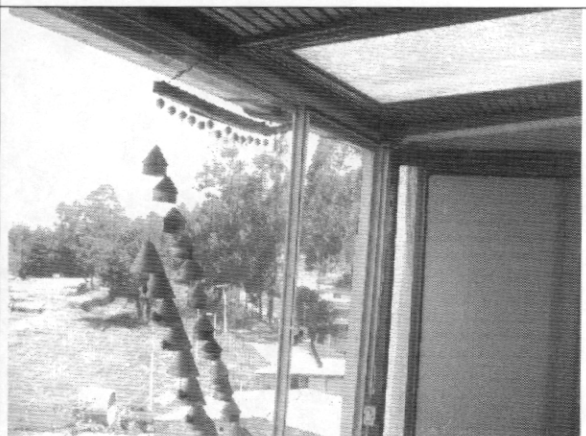
Foto 6. Cielo raso bajo cubierta en buen estado
