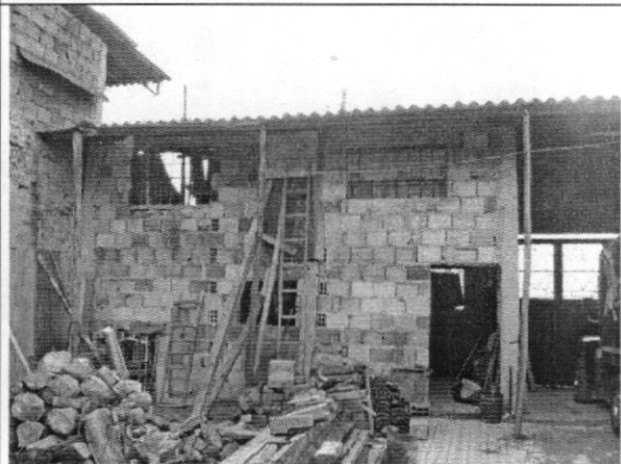
Foto 4. Edificación del sector frontal en construcción
