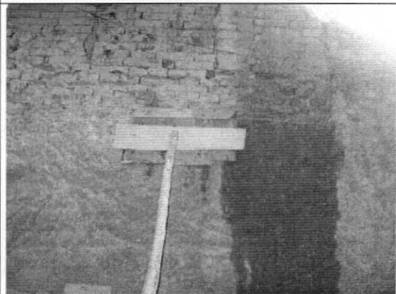
Foto 12. Muro de lindero del predio vecino del costado sur
