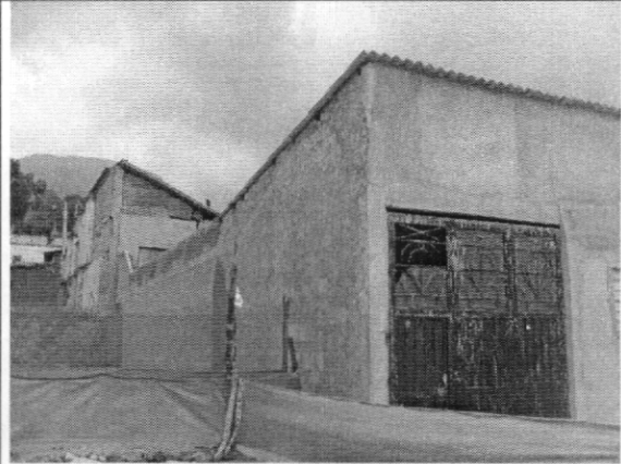
Foto 2. Muro de lindero costado norte, cara externa
