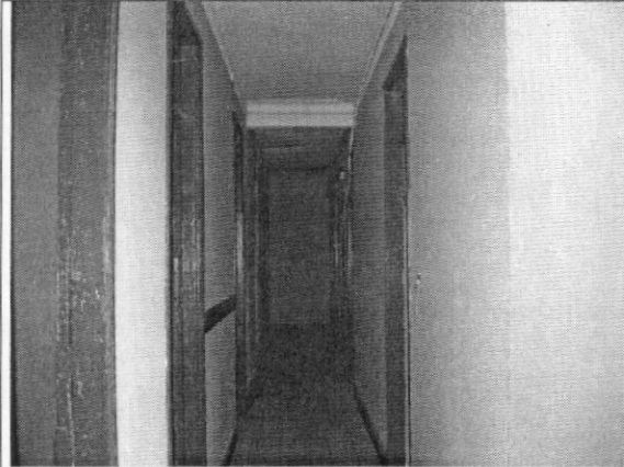
Foto 3. Muros internos en buen estado
