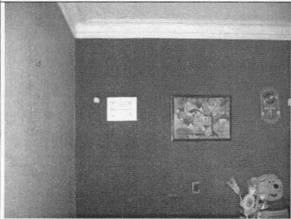
Foto 5. Muros internos sin afectaciones graves
