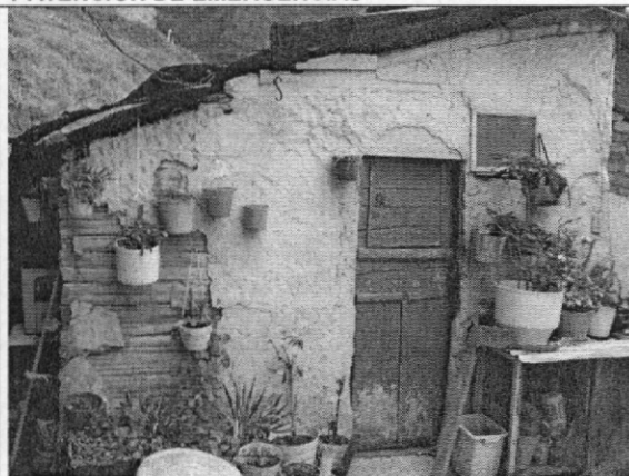
Foto 10. Aspecto externo de la edificación central
