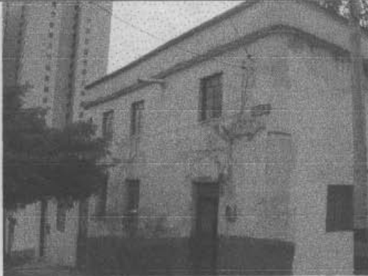
Foto 1. Muro Fachada Oriental.
