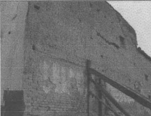
Foto 3. Muro fachada Occidental.
