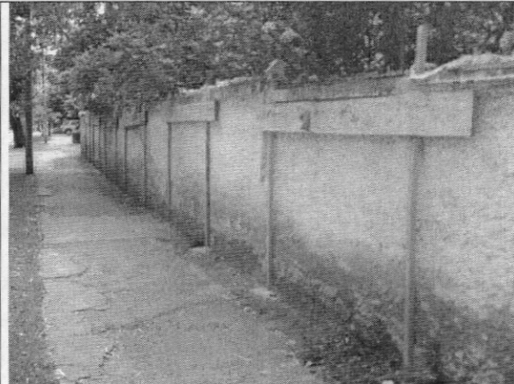
Foto 6. Apuntalamiento provisional con elementos de madera
