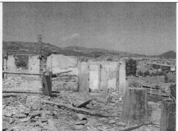
Foto 10. Soportes en concreto para maquinaria
