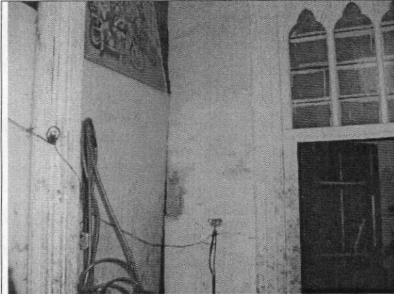
Foto 3. Muros internos y división con el predio contiguo
