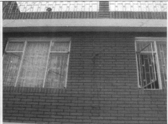
Foto 2. Muros de fachada en buen estado
