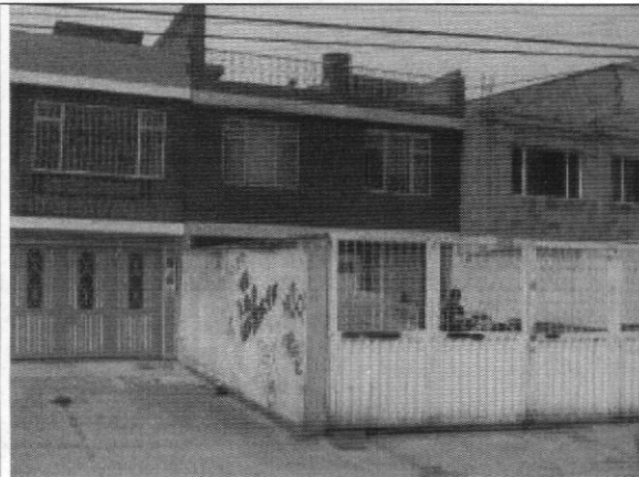
Foto 1. Vista general del inmueble
