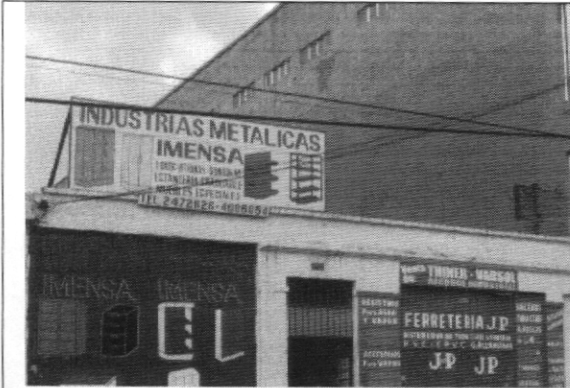
Foto 1. Vista general de la fachada del inmueble
