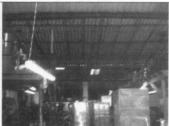
Foto 6. Cubierta zona posterior en buen estado
