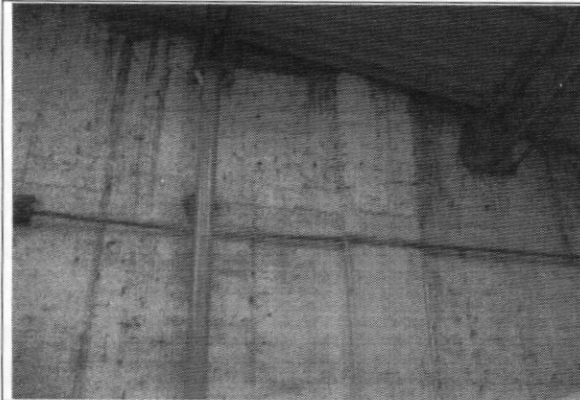
Foto 3. Muros zona posterior en buenas condiciones
