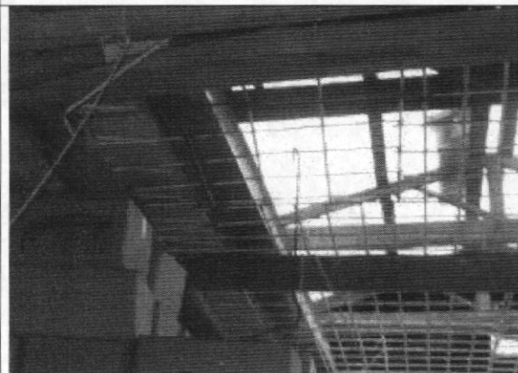
Foto 5. Cubierta parte posterior
