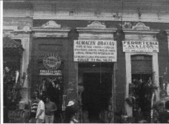
Foto 1. Vista general del inmueble
