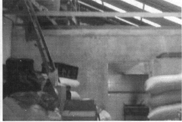
Foto 4. Muros parte posterior, buenas condiciones
