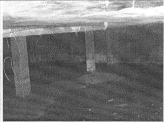
Foto 6. Aspecto general del sótano
