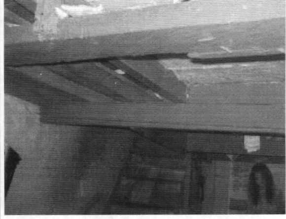
Foto 4. Estructura de madera soporte mezanine
