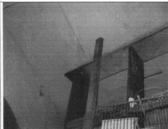
Foto 5. Cielo raso en buen estado
