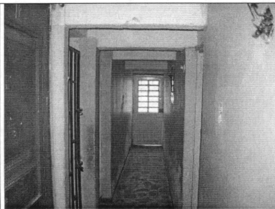
Foto 3. Muros internos de primer piso sin daño visible
