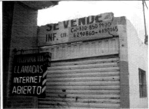
Foto 2. Muro de cerramiento, costado oriental
