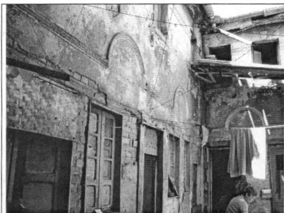
Foto 3. Muros internos del primer piso
