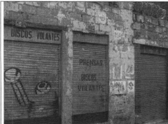
Foto 1. Vista general del muro de fachada
