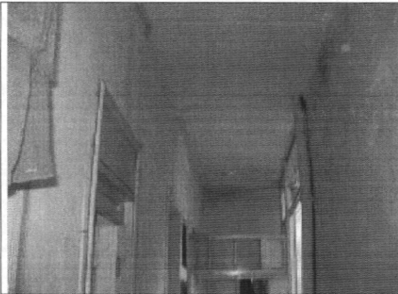
Foto 3. Muros primer piso zona posterior en buen estado
