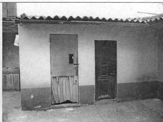
Foto 2. Interior de la edificación, sector frontal
