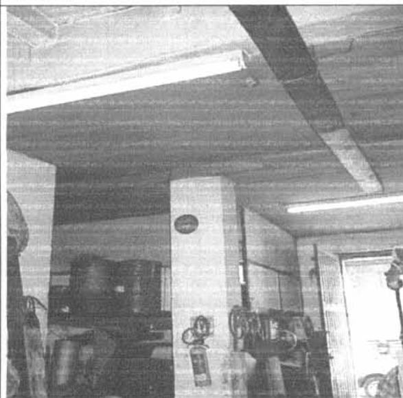
Foto 7. Taller ubicado en el costado sur-oriental del inmueble sin daño aparente en la estructura.
