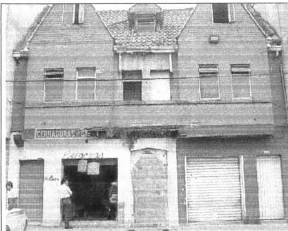
Foto 1. Condiciones de la Edificación – En la fachada.
